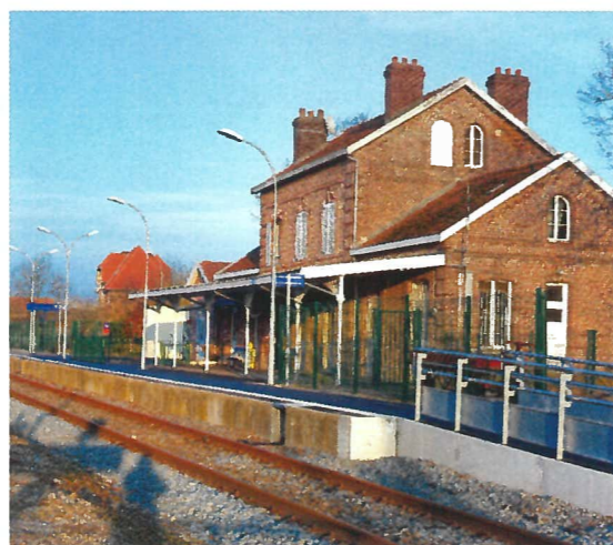
La gare est toujours en activité grâce à la ligne Laon <=> Hirson.
