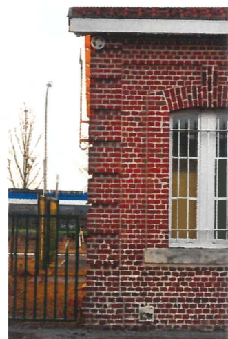
Gros plan sur les chaînages d'angle si particuliers du BV.
