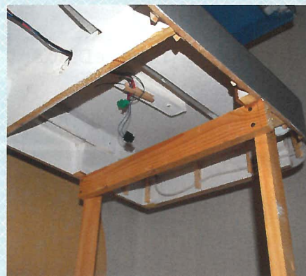
Chaque module comporte des logements pour les pieds qui le supporteront. On peut remarquer que les pinces à linge qui maintiennent en place le rideau lors de la présentation au public servent à tenir des câbles électriques lors des transports et stockages.
